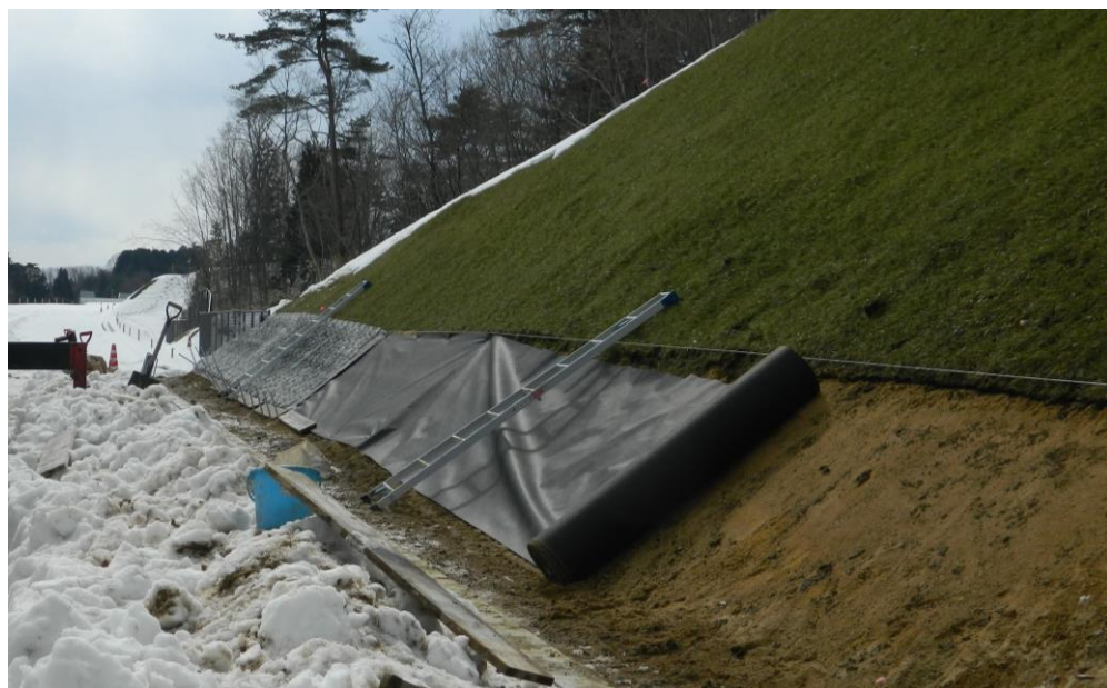
山水コンマット敷設準備 導線用栈木取付
