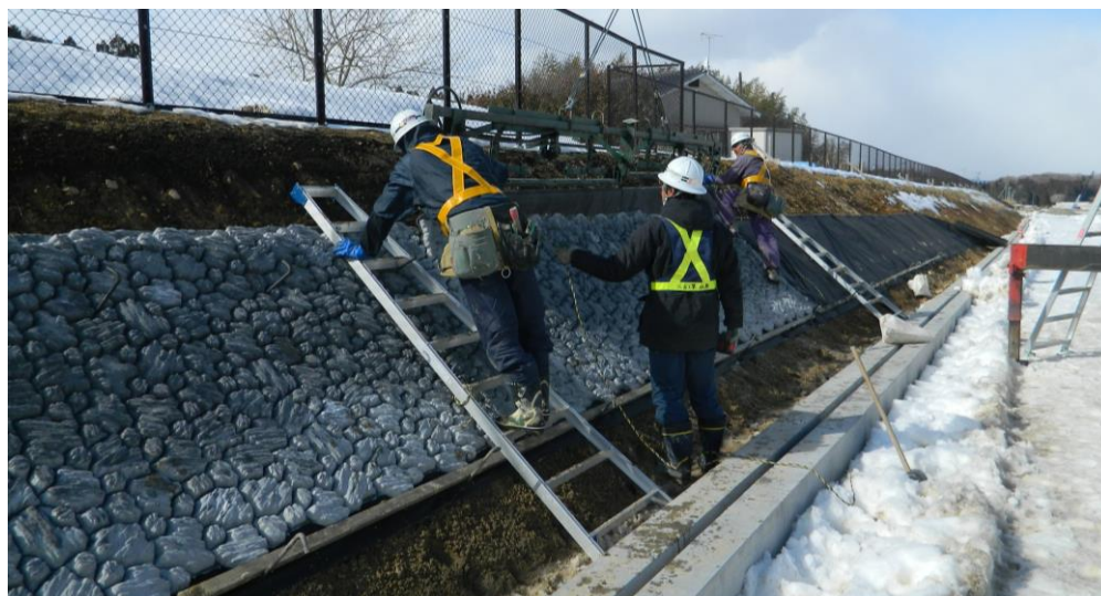
山水コンマット敷設 横吊施工
