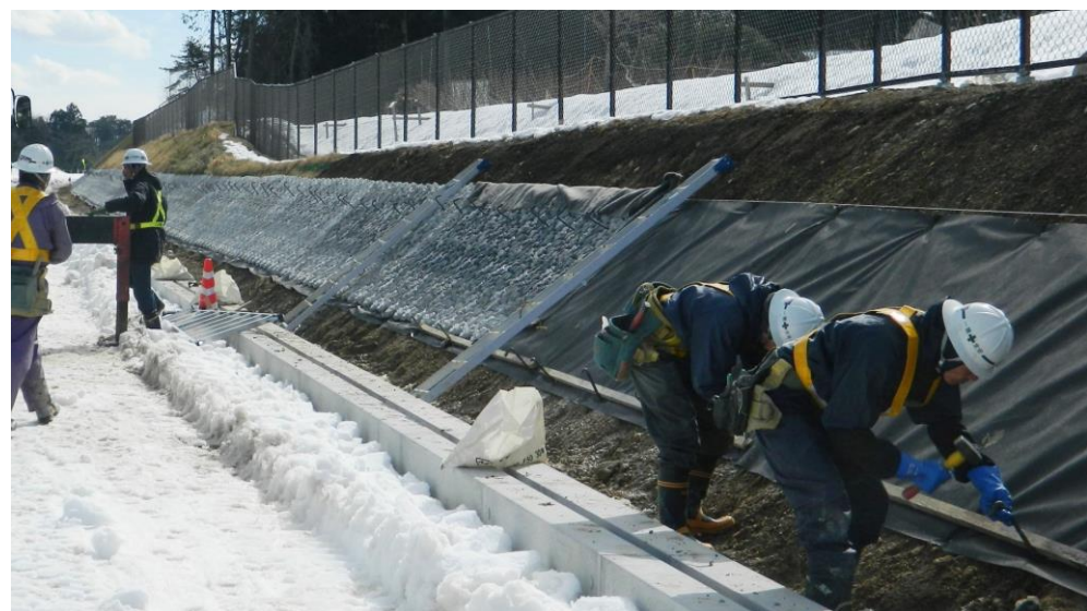
山水コンマット敷設 横吊施工
