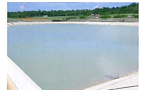
南大東村新東地区貯水池（沖縄県）
