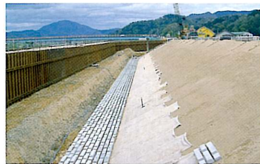
円山川施工中
